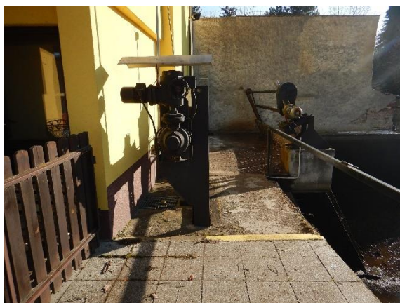
Zastropení nátoků před MVE, v popředí uzavírací stavidlo levého nátoku
