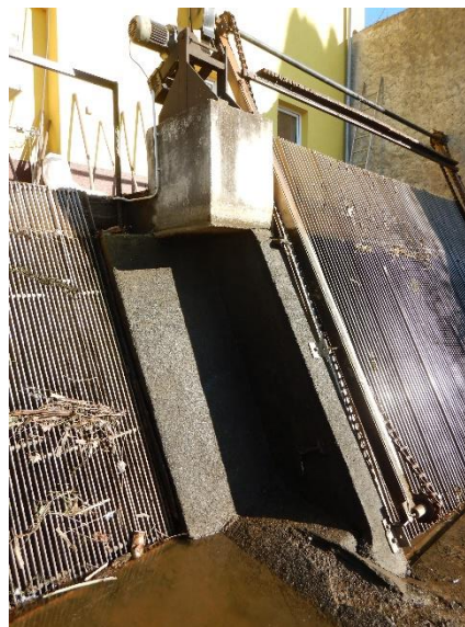
Pravé česlové pole se stíracím řetězovým strojem
