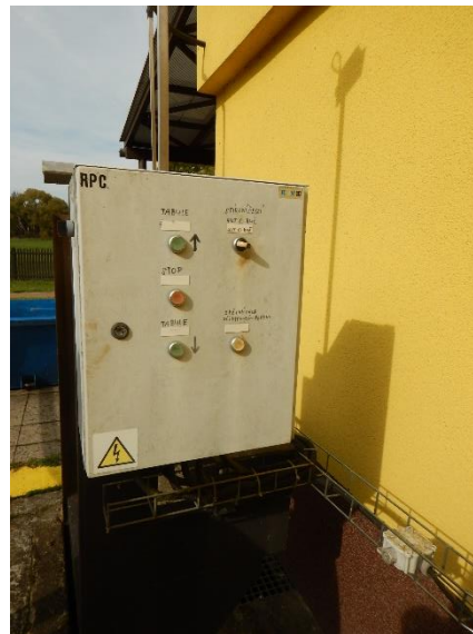
Ovládací skříň stavidlové tabule a stíracího stroje pravého pole TG1
