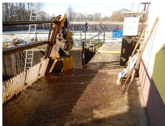
Zastropení nátoků před MVE, vlevo stírací stroj pravého pole TG1
